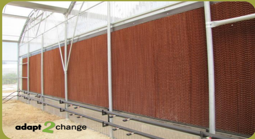
Σύστημα δροσισμού υγρής παρειάς
