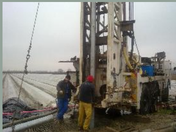
Υδρογεώτρηση Ενεργειακού Σκοπού
