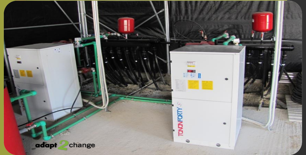
Δύο (2) γεωθερμικές αντλίες θερμότητας δυναμικότητας έκαστης 35 kW
