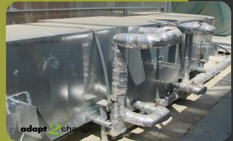
Σύστημα ανακυκλοφορίας αέρα/ αφύγρανση
