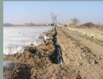
Κεντρικοί Αγωγοί Προσαγωγής- Επιστροφής
