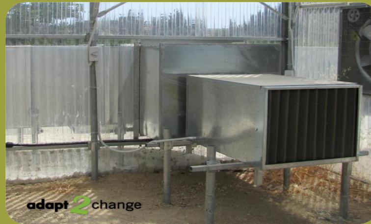
Σύστημα ανακυκλοφορίας αέρα/ αφύγρανση
